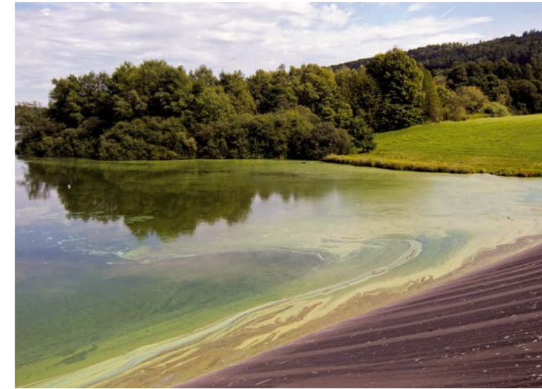
Übermäßiger Algenaufwuchs in einer verschmutzten Talsperre
